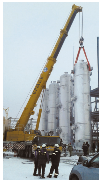
Рис. 3. Монтаж блока осушки на площадке Вынгапуровского ГПЗ в рамках реализации проекта «Расширение Вынгапуровского ГПЗ. Строительство установки переработки газа №2 (УПГ-2)»
