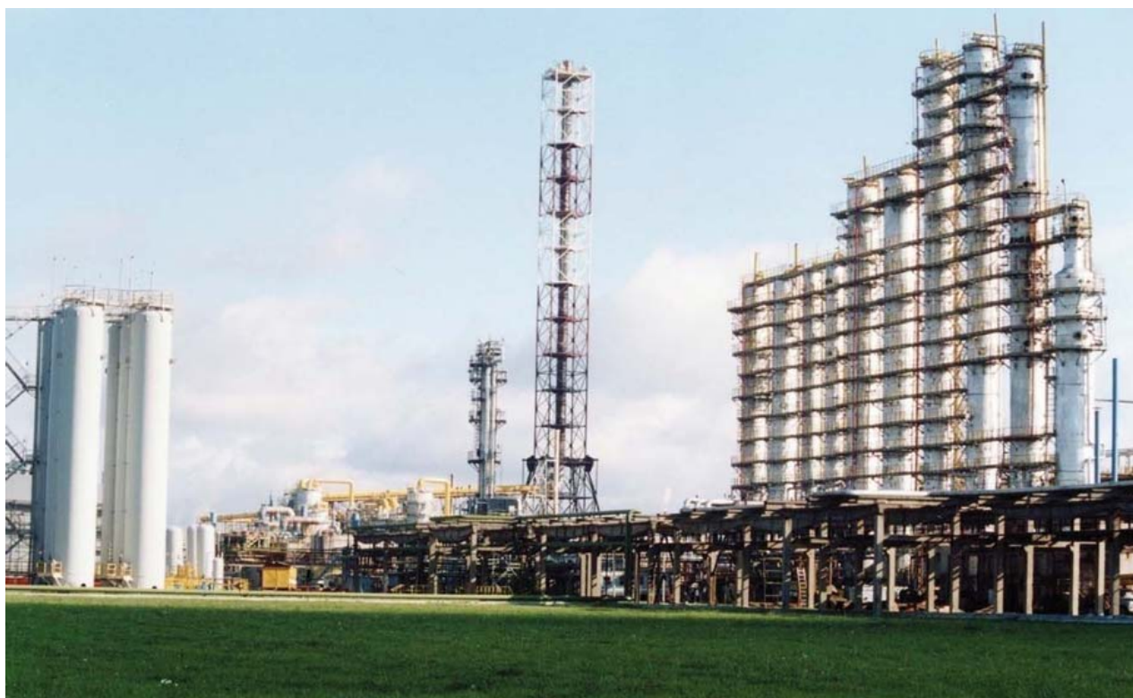
Рис. 2 Газофракционирующая установка (ГФУ) в ООО
